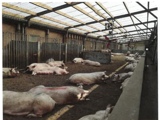
Door het dak te laten krijten, wordt de temperatuur met 8 tot 10 graden teruggebracht. Ook de kosten zijn beperkt; 50 cent/m 2 .
